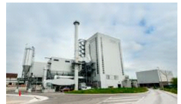
La centrale biomasse de Novillars relance la papeterie Gemdoub
