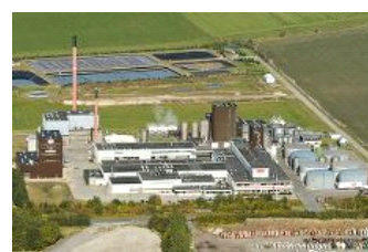
Un nouveau système AET SNCR DeNOx mis en service
