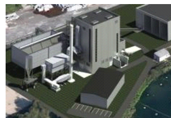
La centrale Cogénération biomasse de Novillars (CBN).
