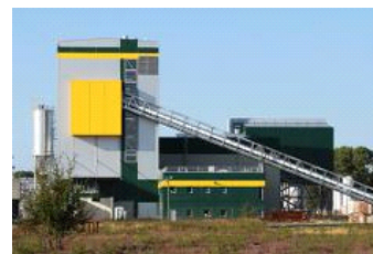
Biomass Energy Solutions à Vielle Saint Girons, France.
