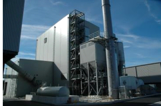
La centrale électrique Western Wood du pays des Galles dispose d'une chaudière à rendement très élevé et l'une des plus hautes disponibilités du Royaume Uni
