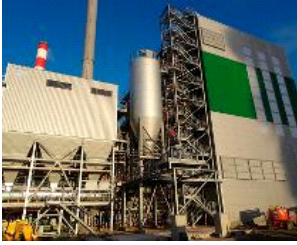
Le projet Biolacq Energies, à Lacq, est une centrale de cogénération à biomasse d'une puissance thermique de 54 MW, alimentée avec du bois forestier et des résidus propres et non contaminés provenant de En lire plus sur le projet Biolacq.
