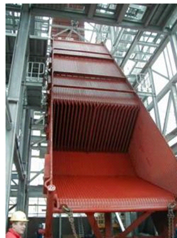
Installation de la section du surchauffeur de la chaudière
