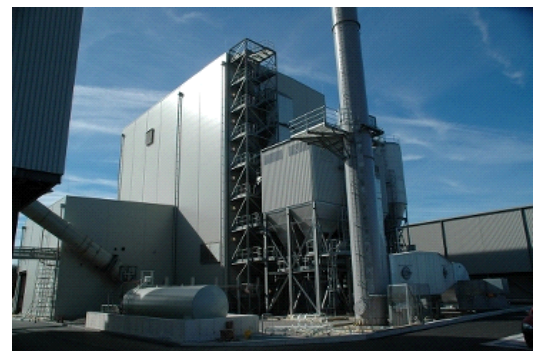
La centrale électrique Western Wood a un rendement net de 30%, bien que conçue en 2005.
