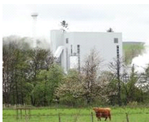
La centrale Rothes CoRDe Ltd est une centrale de cogénération à la biomasse.
