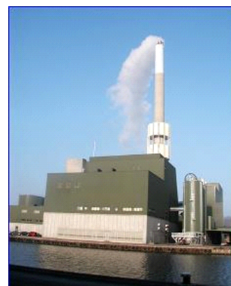
La centrale de cogénération de Randers a changé de nom, de Randers Energi à Verdo, afin de signaler qu'elle utilise à présent de l'énergie renouvelable
