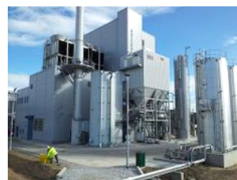
La centrale CHP Rothes CoRDe en Écosse produit 8,0 MW de chaleur et 8,4 MWe d'électricité.
