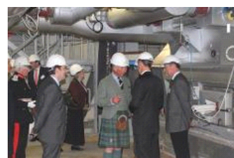
Le 16 avril 2013, SAR le Prince Charles, duc de Rothesay, a officiellement inauguré la centrale de cogénération chaleur-électricité à la biomasse Rothes CoRDe de 8,3 MWe à Rothes, Morayshire, en Écosse.
