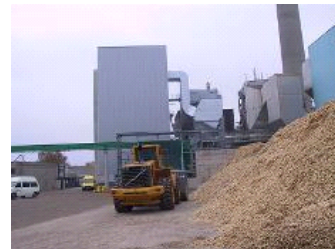
Linz-Mitte Energie Anlage en Autriche utilise du bois non contaminé pour combustible.
