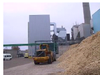
Linz-Mitte Energie Anlage en Autriche utilise du bois non contaminé pour combustible.
