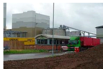
L'usine est en construction.
