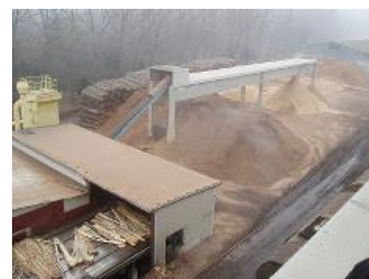
La centrale CHP à la biomasse de FunderMax utilise pour combustible des déchets de bois provenant de la production des agglomérés et contreplaqués.
