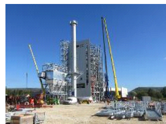
L'usine est en construction (OCT 2017).
