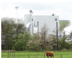
La centrale Roth's CoRDe Ltd est une centrale de cogénération à la biomasse,
