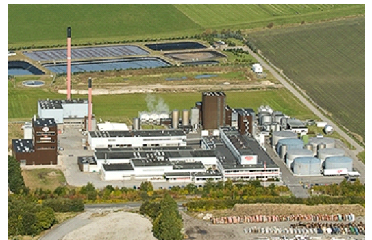
De Danske Gærfabrikker (DDG) réduit les émissions de NO x d'env. 50% en utilisant le système AET SNCR DeNOx.
