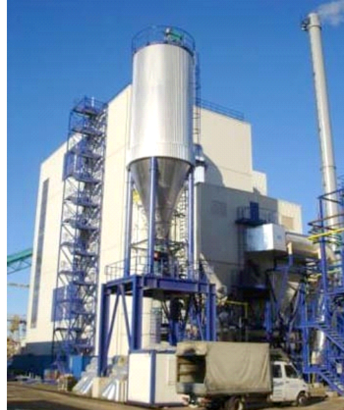
FunderMax a réduit les émissions de NO x env. 80% en utilisant le système AET SNCR DeNOx.
