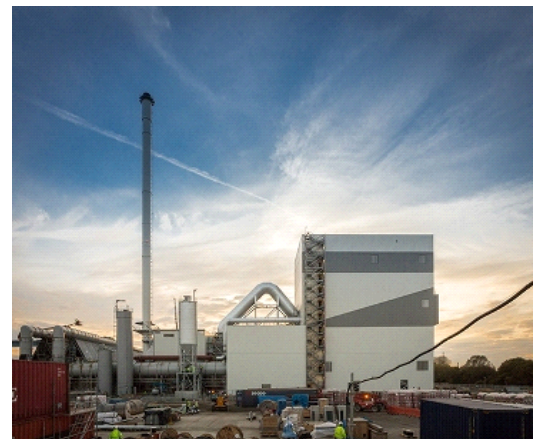
À Tilbury Green Power, le système DeNOx AET SNCR a réduit les émissions de NO x d'environ 70 %.
