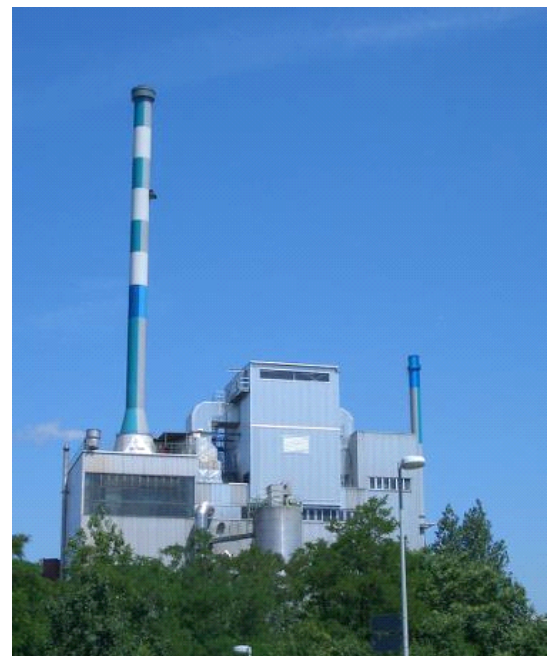
Boehringer Ingelheim Pharma KG, Allemagne, une centrale électrique ayant une capacité de 70 MW, utilise des déchets de bois comme combustible.
