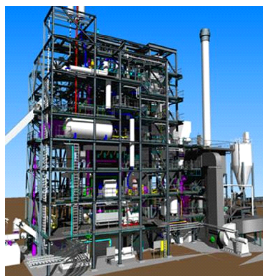
La centrale de cogénération Cofely GDF-SUEZ est en cours de construction à Orléans, en France.
