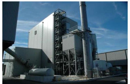
La centrale électrique Western Wood à la biomasse produit 15 MWe d'électricité.
