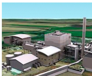
JG Pears, Newark, est une centrale de cogénération de 42 MW alimentée par des MBM. Elle a été mise en service en 2018.
