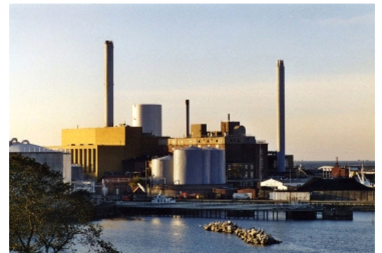
Østkraft centrales à la biomasse.
