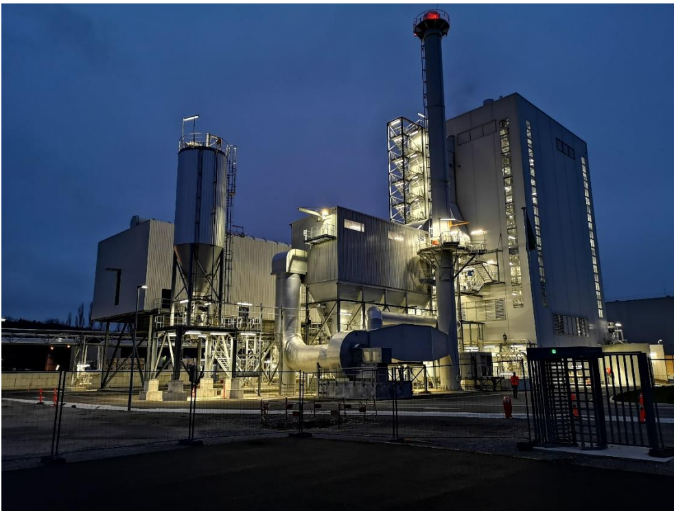
Cogénération Biomasse de Novillars.
