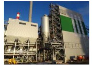
Le projet Biolacq Energies, à Lacq, est une centrale de cogénération à biomasse d'une puissance thermique de 54 MW, alimentée avec du bois forestier et des résidus propres et non contaminés provenant de
