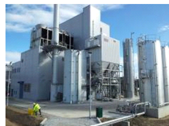
La centrale en cogénération à biomasse d'Helius CoRDe une mise en service réussie
