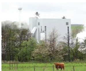
La centrale Rothes CoRDe Ltd est une centrale de cogénération à la biomasse.
