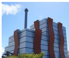
La centrale de cogénération SODC d'Orléans alimentera 15 000 logements.
