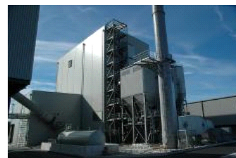
Centrale électrique Western Wood, Pays de Galles - Royaume Uni
