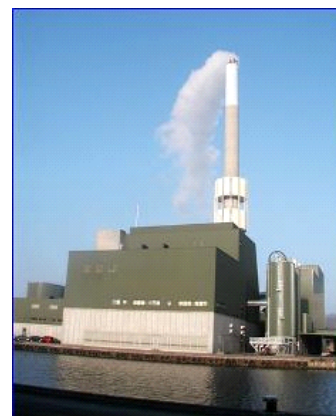
La centrale de cogénération de Randers a changé de nom, de Randers Energi à Verdo, afin de signaler qu'elle utilise à présent de l'énergie renouvelable
