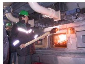
La première mise en service de la centrale CHP à la biomasse de Linz Mitte.
