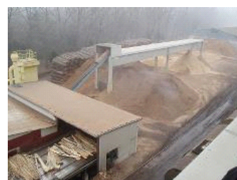
La centrale CHP à la biomasse de FunderMax utilise pour combustible des déchets de bois provenant de la production des agglomérés et contreplaqués.
