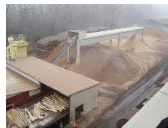
La centrale CHP à la biomasse de FunderMax utilise pour combustible des déchets de bois provenant de la production des agglomérés et contreplaqués.
