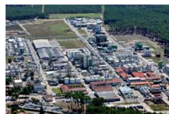
Vue aérienne de l'emplacement de DRT à Vielle-Saint-Girons dans les Landes.
