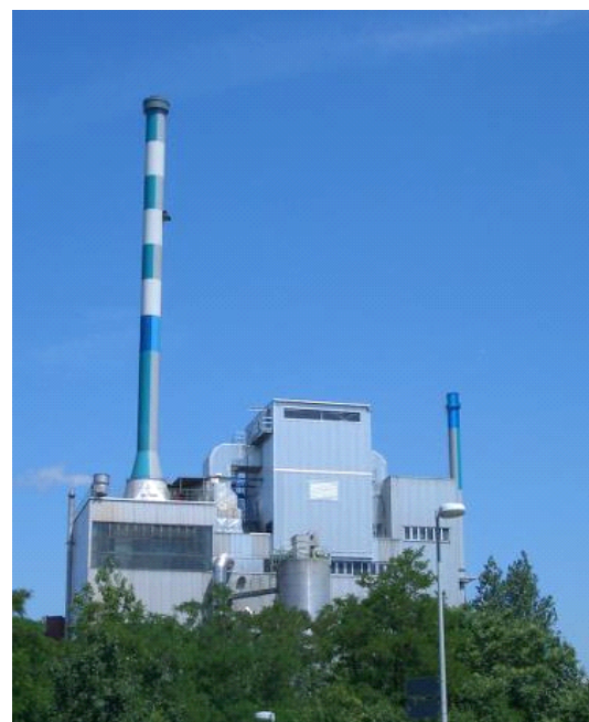
Boehringer Ingelheim Pharma KG, Allemagne, une centrale électrique ayant une capacité de 70 MW, utilise des déchets de bois comme combustible.
