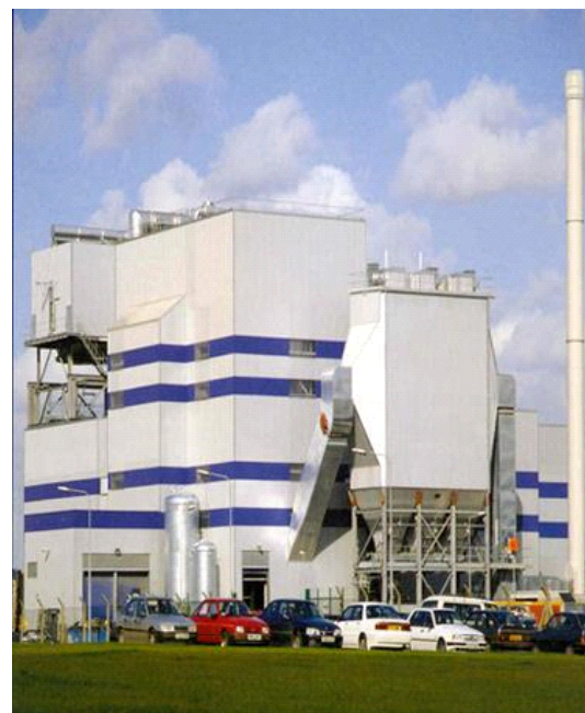
La centrale électrique EPRL Fibrogen
