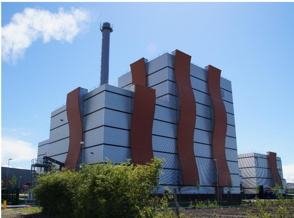
*Die biomassebefeuerte SODC Anlage in Orléans ist jetzt in Betrieb. Die gemessenen Leistungen übertreffen die garantierten Werte. Der Kesselwirkungsgrad liegt über 92%.*
